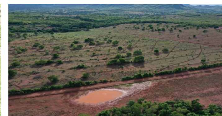
Marcação curvas de nível para terraço, Faz. São José Localidade: Bacia do Córrego Fundo, Barra do Garças/MT
